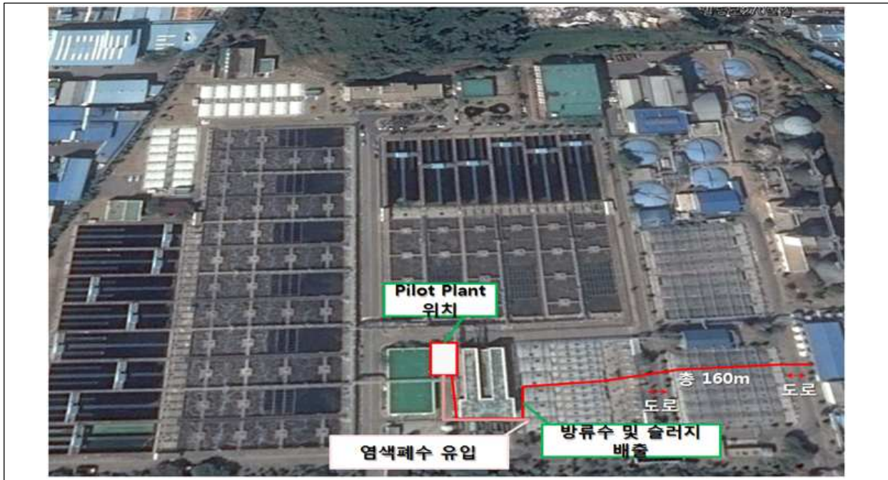
(안산하수처리장 내 Pilot Plant 위치 및 유입수 배관 구성)
